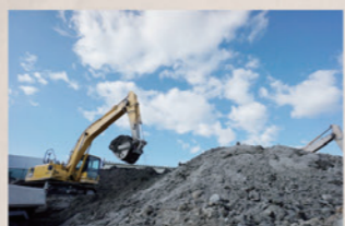
CONSTRUCTION SLUDGE 建設汚泥処理
